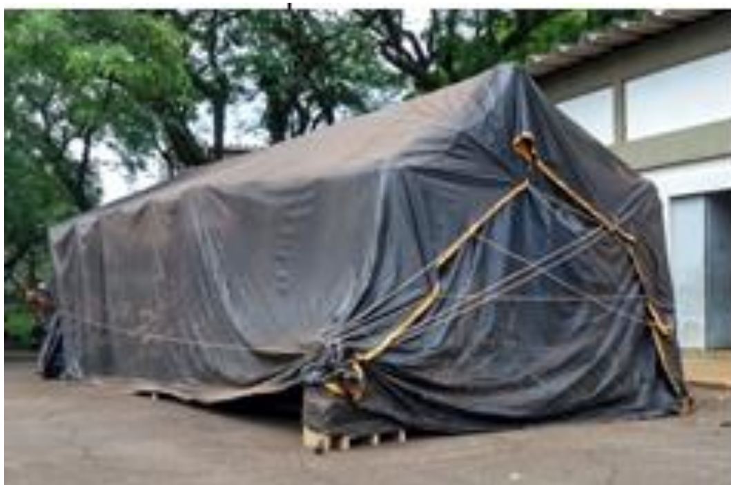
Figura 11. Prédio da Casa de Máquinas, a mudança de layout interno possibilitou acomodar todos os equipamentos anteriormente alocados mais trazidos do Prédio I. Ainda a
