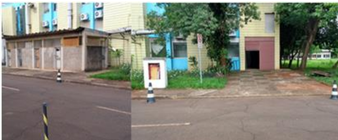
Figura 10. Prédio I, remoção de entulhos e equipamentos externo ao Prédio 1 de forma a
