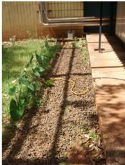
Figura 4. Nivelamento do terreno ao lado do Prédio I, utilizando areia e pedra brita para
